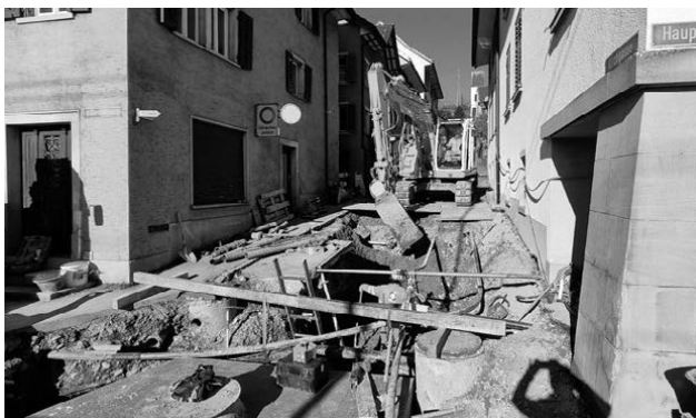
Eindolung Goldbergbach anlässlich des Baubeginns
