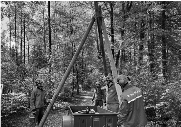
Hilfskonstruktion zum Heben von Lasten
