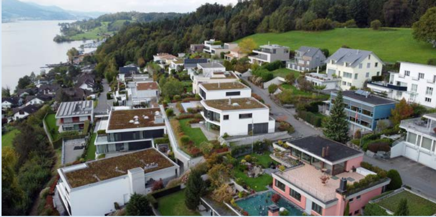
Haldenstrasse und Sonnenhalde
