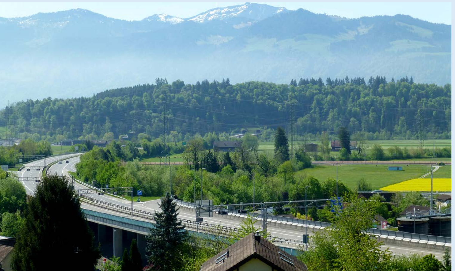
Autobahnzubringer A15 und Portal Nord Buech- bergtunnel (Foto HPK)
